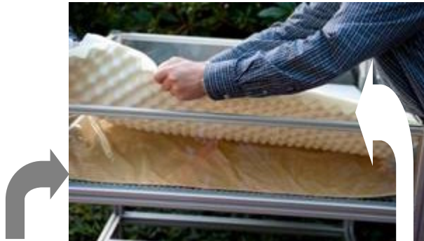
Lámina impermeabilizante de Polyurea.
