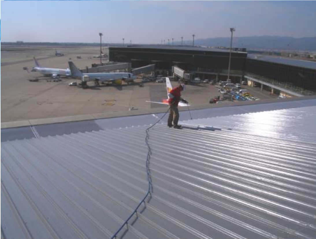
Aeropuerto de Barcelona Rehabilitación cubiertas pre-embarque Sistema Impermax Plus Arq. Ineco Ing.
